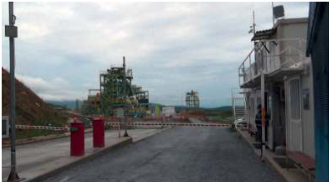
Die gut gesicherte Einfahrt auf das Werksgelände von Eldorado (oben)
